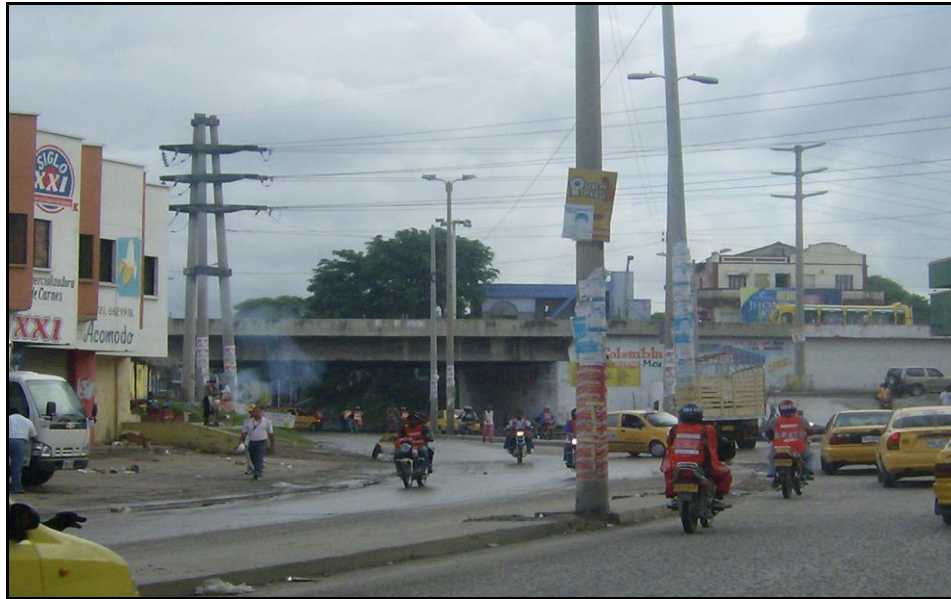
Figura 1.5 Vista del puente Bazurto, el cual se tiene proyectado demoler
