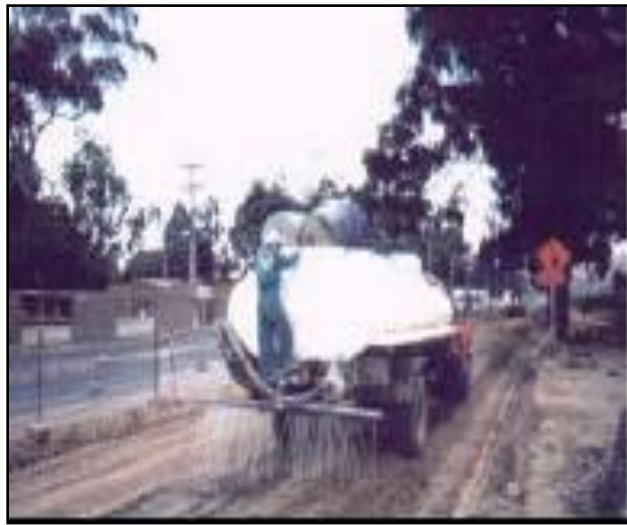
Figura 8.24 Humectación de zonas desprovistas de acabados
