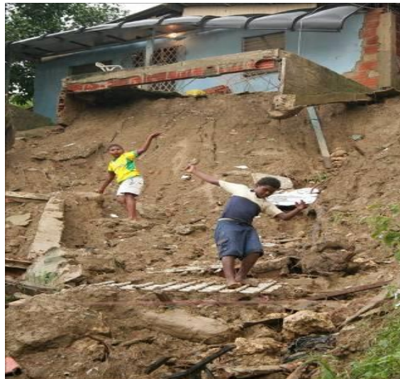
Figura 2.6 Deslizamientos sobre viviendas en el cerro de la Popa
