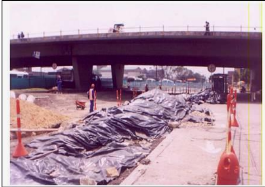
Figura 8.6 Cubrimiento de escombros con plástico
