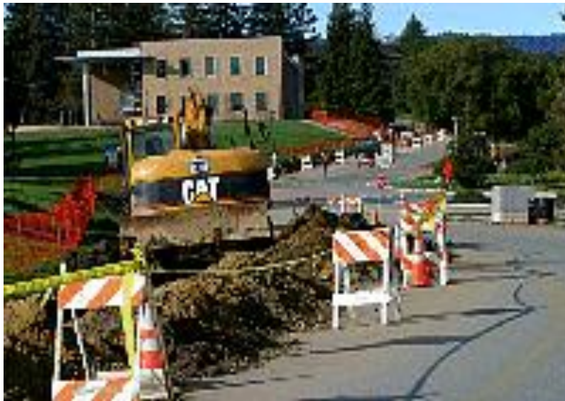
Figura 8.16 Señalización de Excavaciones en Frentes de Obra
